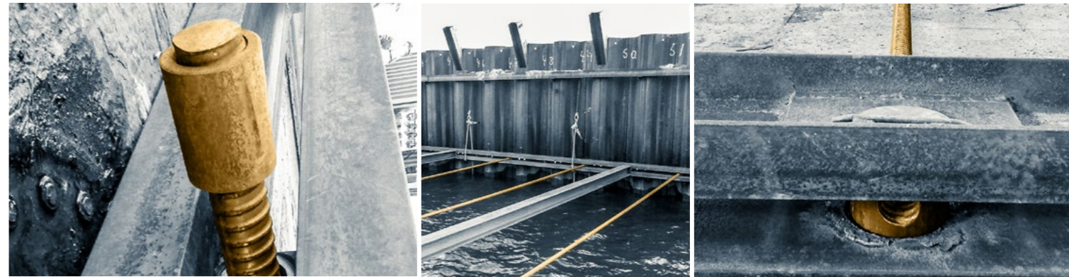
Hafenanlage, Køge Hafen
